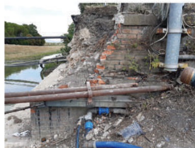
Demolizione del ponte esistente
